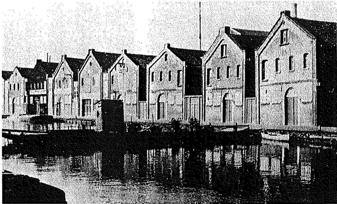
Rij branderijgevels aan de Noordvestsingel in Schiedam. Op de voorgrond lag toen nog een schipbrug voor voetgangers en fietsers, deze is al verdwenen. De gevels zijn nog gedeeltelijk intact.
