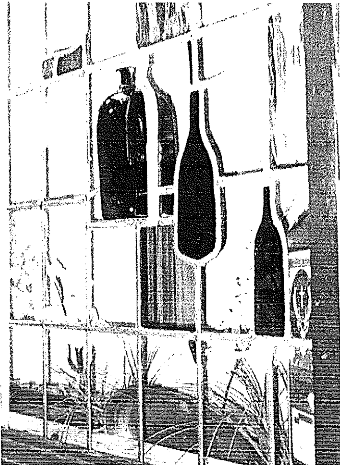
Marcel Verhaaf kiekte in het Limburgse Vaals dit bijzondere 'Fles in lood-raam'. De twee flessen rechts zijn van vlak glas, zoals te doen gebruikelijk in glas in lood. De linkerfles is een echte fles die in het raam gemonteerd is. Het is een vierkante, redelijk oude fles, die zich moeilijk dateren liet.
