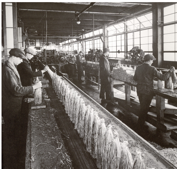
Boven: Exportbierflessen worden voorzien van strohulzen. Een beeld van de verpakkingslijn bij de Amstel brouwerij, 1930.
