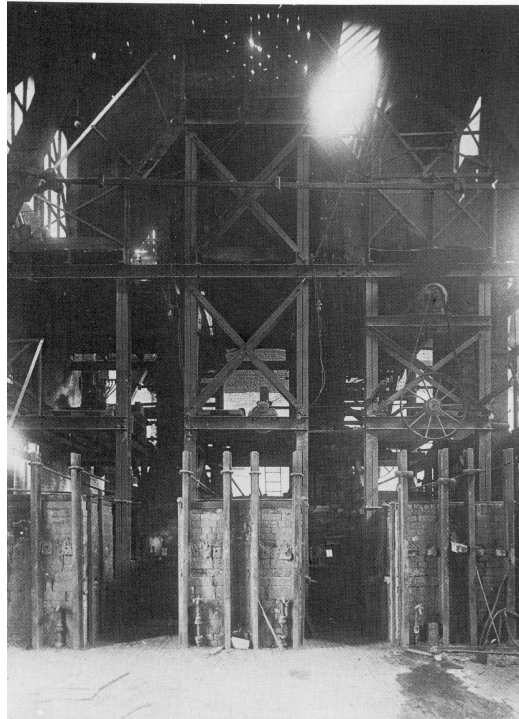
Links: Oudste foto (vooraanzicht) van een Fourcault installatie, speciaal gemaakt voor de uitgave van Robert Dralle's boek 'Die Glasfabrikation' München-Berlijn, 1911.
